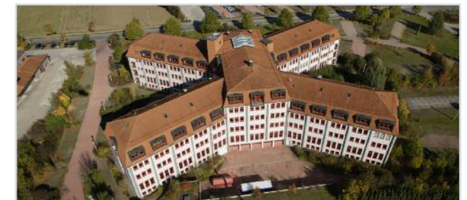
Verwaltungsgebäude in Weismain.
